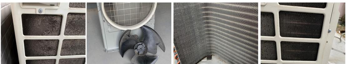
外せる部品を外し、電装部に水がかからない様にしっかりと養生し、アルミフィン、ファン、外装の汚れを高圧洗浄でしっかり落とします。
